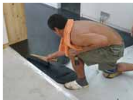
Die Fa. Arge-Gussasphalt bei der Arbeit
