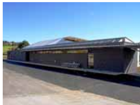
Nordansicht mit Nebeneingang
